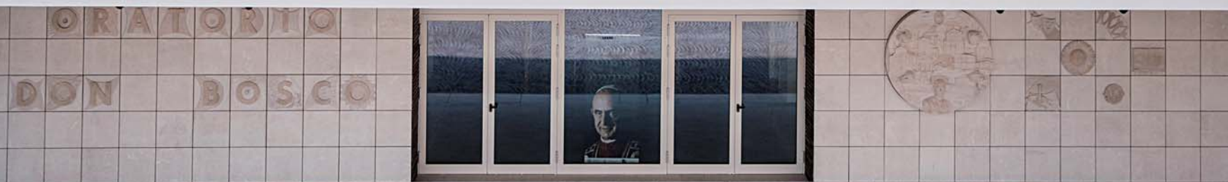
L'ingresso principale della sala polivalente dallo spazio pubblico - scultura e opere in marmo sulle facciate laterali
